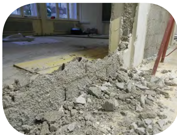
Abbattimento dei muri, Zell am See School, Austria
